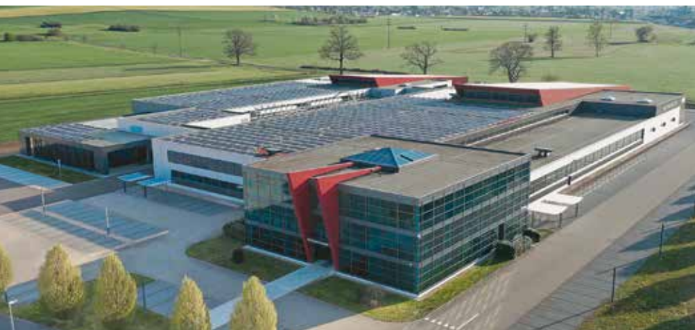
Le siège social à Delémont qui réunit environ 300 collaborateurs/trices. En arrière-plan, l'agrandissement réalisé en 2021 qui regroupe la halle de mise en train, le nouveau tech-center, le service Qualité, une nouvelle salle de métrologie dernier cri et le service Support clients.
