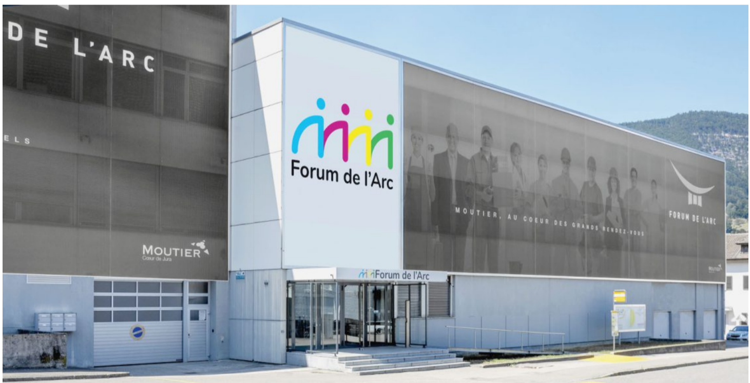
Le Forum de l'Arc de Moutier accueillera les exposants, du 10 au 13 novembre, sur une surface de 11 500 m 2 . ARCHIVES
