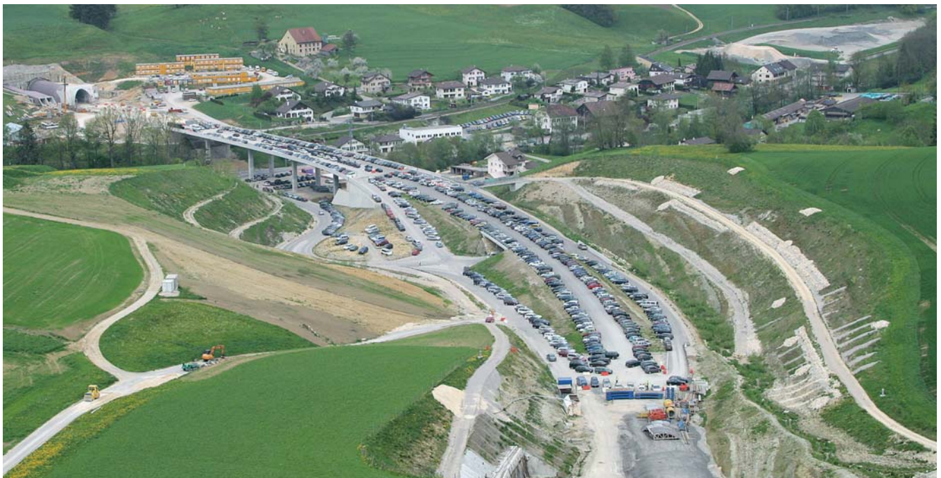
Parking sur l'autoroute en construction (2016)
