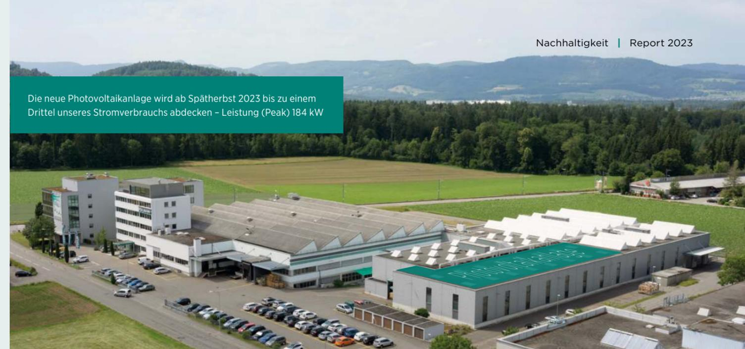
Die neue Photovoltaikanlage wird ab Spätherbst 2023 bis zu einem Drittel unseres Stromverbrauchs abdecken – Leistung (Peak) 184 kW
