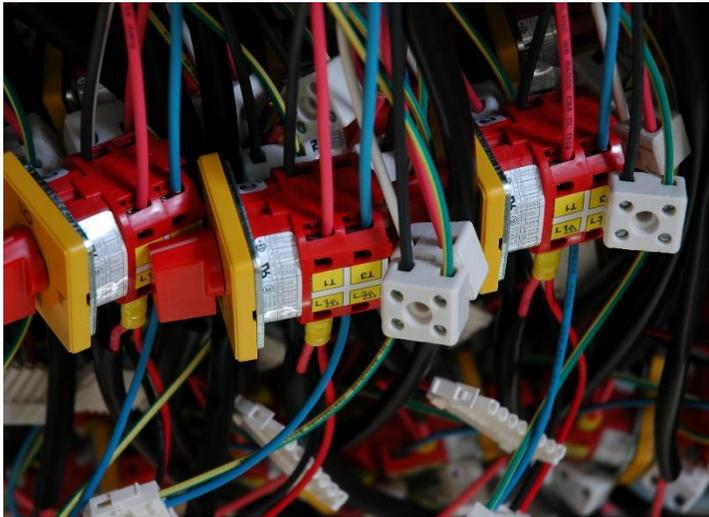
**Interrupteurs & Protection moteur**
