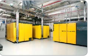
Trocken verdichtende Schraubenkompressoren Wo dieses Verdichtungsprinzip vorausgesetzt wird, überzeugen die innovativen Trockenläufer mit sprichwörtlicher KAESER-Qualität.
