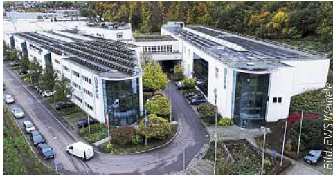
Luftaufnahme des EWS-Hauptsitzes in Uhingen (D) – modernes Fertigungs- und Entwicklungszentrum für Präzisionswerkzeughalter mit hoher Eigenfertigungstiefe.
